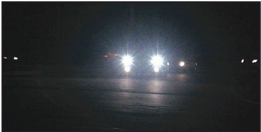
Lampu jalan yang kurang terang
